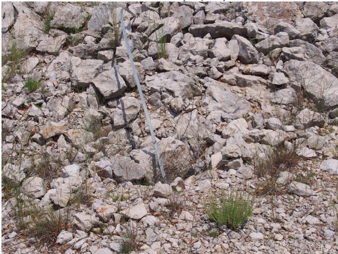
Slika 11. Gromobranske instalacije na području obuhvata
